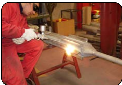
Наплавка износостойкого слоя с помощью горелки SuperJet-S
